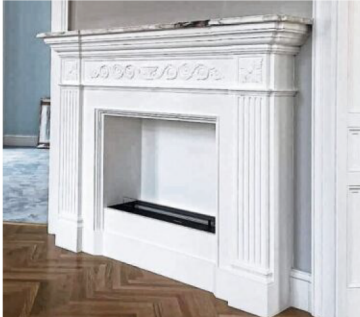
Auch das ist Stuck: individuelle Kaminverkleidungen aus Einzelteilen.
