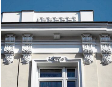
... die mit 25 Gussformen und 730 Abgüssen vervollständigt wurden.
