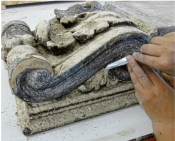
Aus restaurierten Altteilen werden Gussformen für die Nachproduktion.
